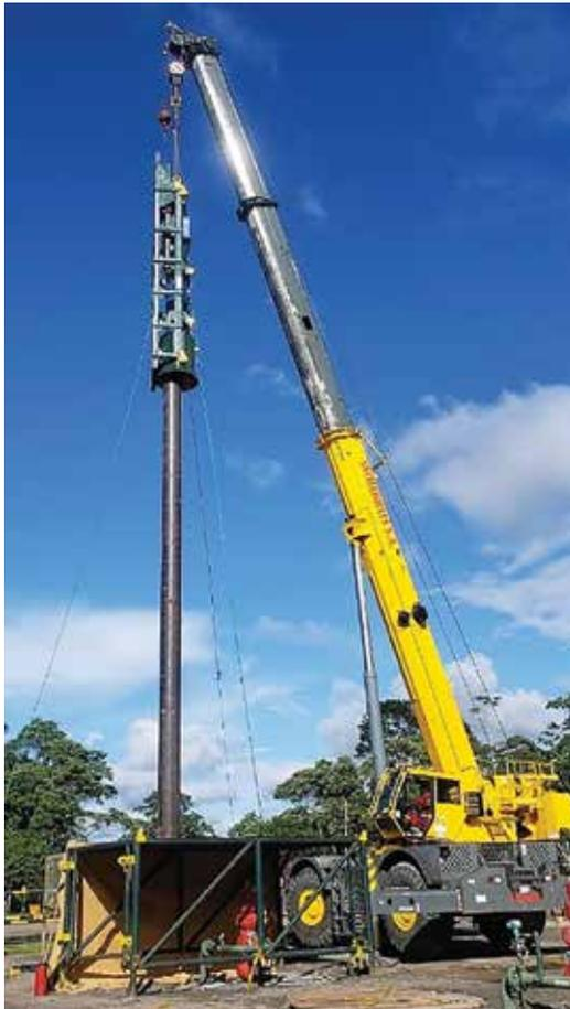
Figura 8. Hincado de Tubería Conductora.
