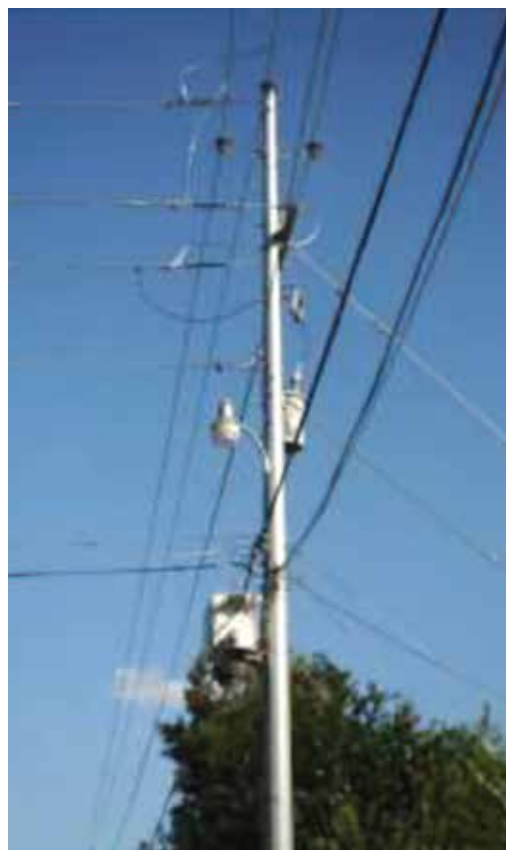
Imagen 13. Los postes de acero GIC evitan fallas catastróficas por efecto cascada y fortalecen las líneas de distribución y subtransmisión. [33]
