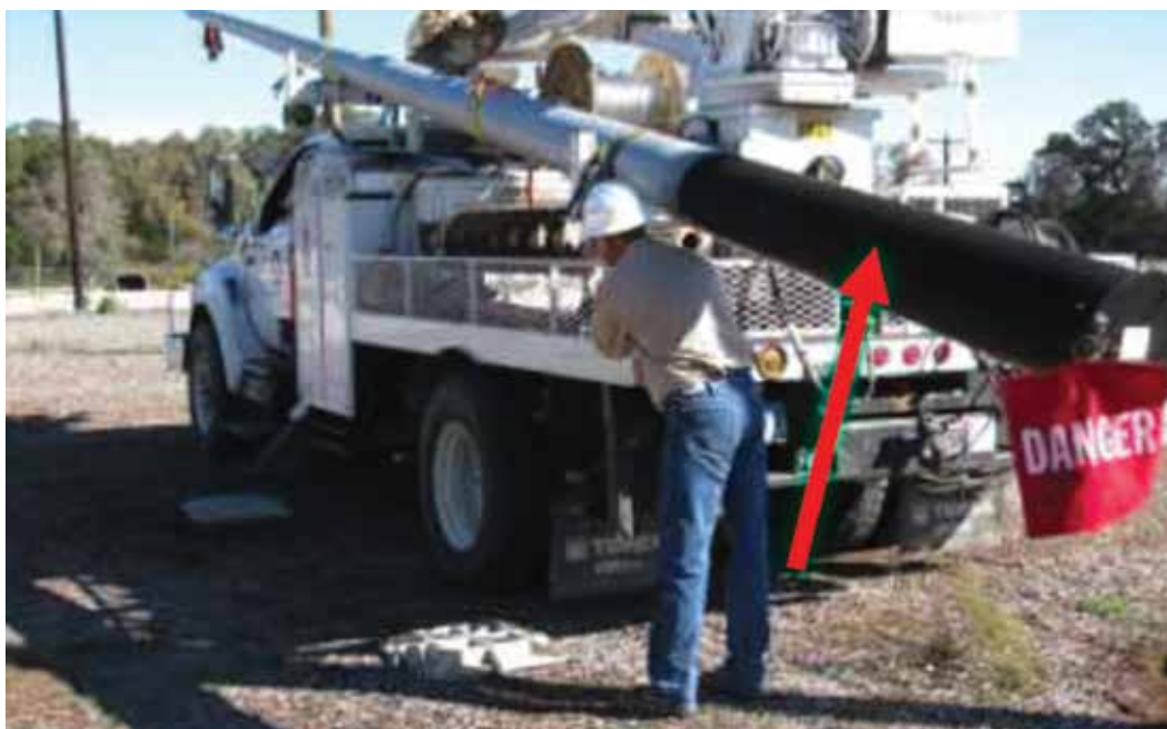
Imagen 15. Debido a que los postes de acero GIC se desempeñan también en el subsuelo, es posible aplicar sistema dúplex para aumentar la protección y el tiempo de vida en esa zona que enfrentará otras condiciones. [33]
