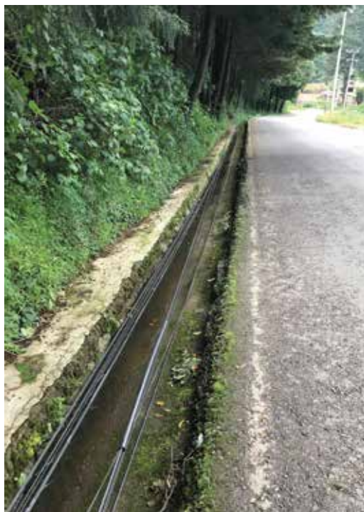
Imagen 9: Los cables al nivel del piso representan un riesgo para los transeúntes además de interrupciones en el servicio y que obviamente conllevan pérdidas económicas Jilotzingo, Estado de México, septiembre 2021. Fuente: Biblioteca IZA Latinoamérica.
